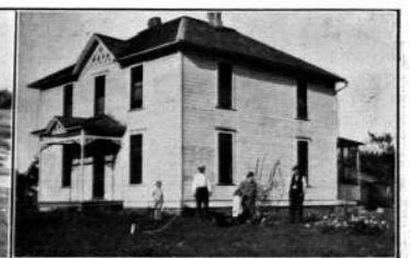
L. F. PLEGE RESIDENCE Lebanon, Mo.
