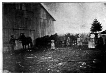
BARN OF R. L. DIGBY Delto, Mo.
